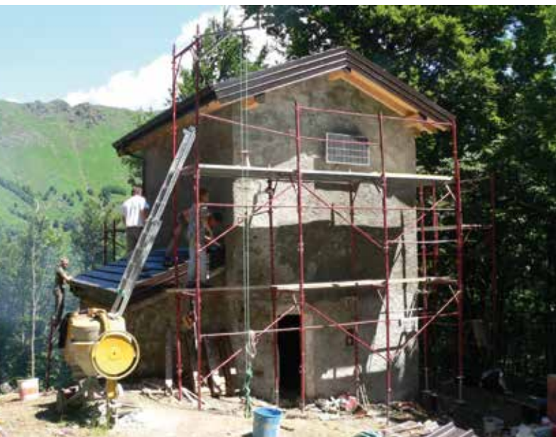
Una fase dei lavori di ristrutturazione del Rifugio Fraccia.
