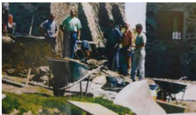
Alcuni momenti della ristrutturazione dell'Alpe Palù.
