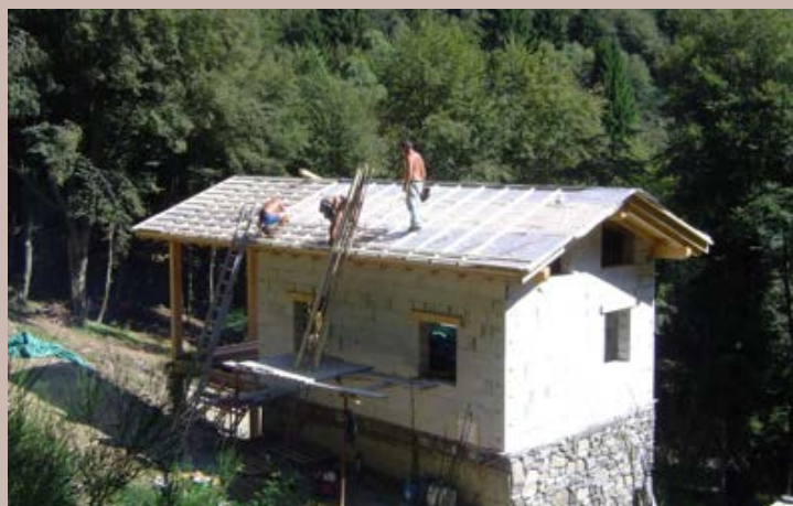
La realizzazione del tetto
