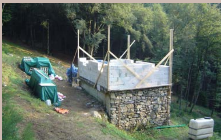
Consolidamento delle fondamenta e del pian terreno
